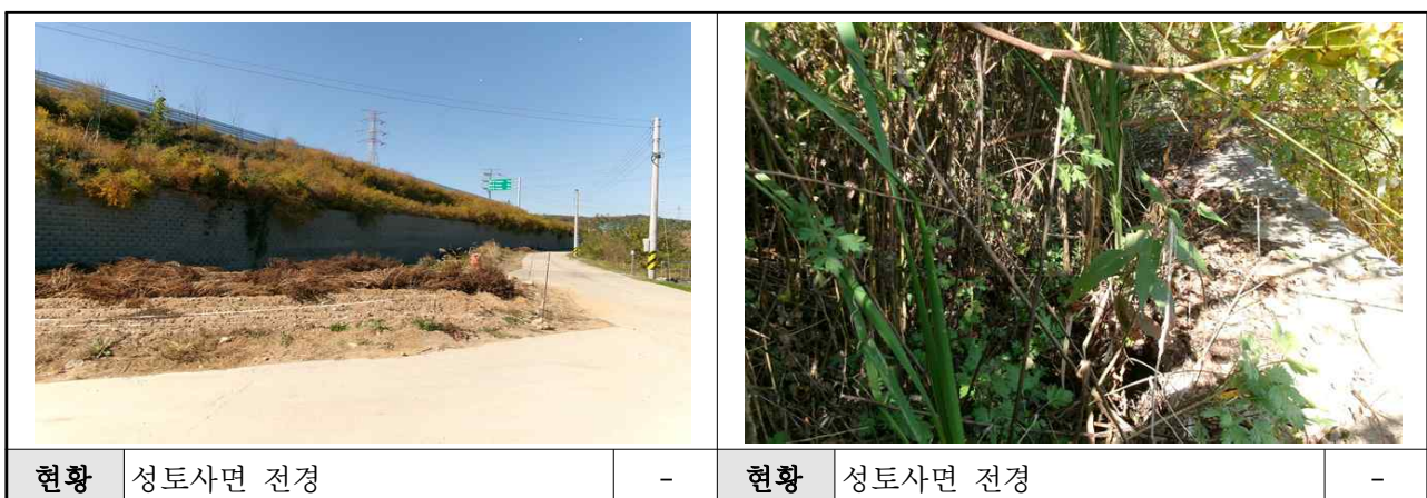
【사진 8.5】 옹벽 상단부 현황
