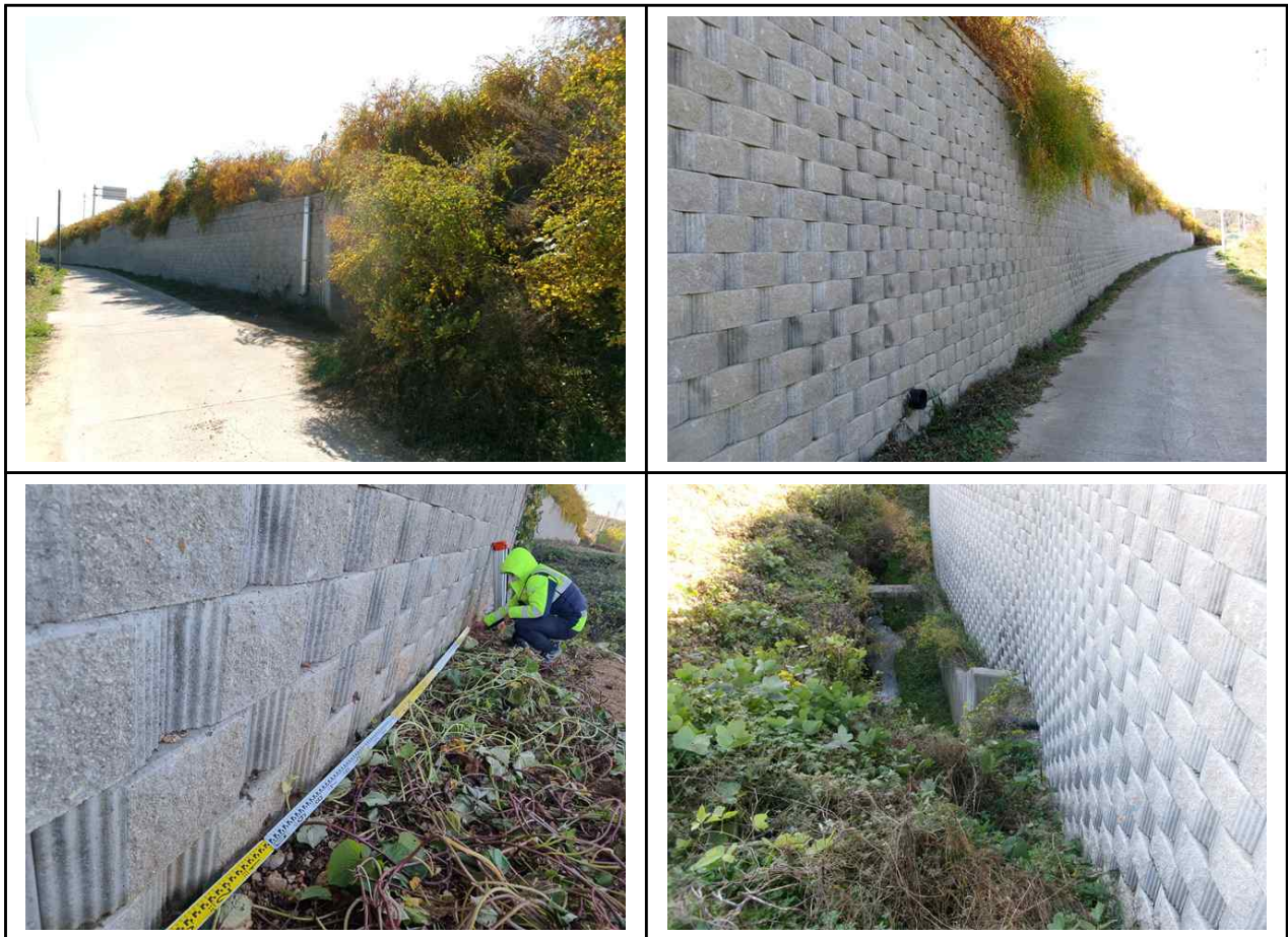
【사진 8.2】 외관조사 전경
